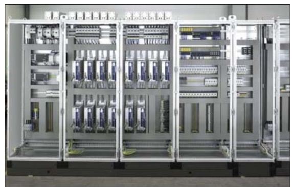
Bild 3: Schaltschrank mit WATT Umrichtern P6000
