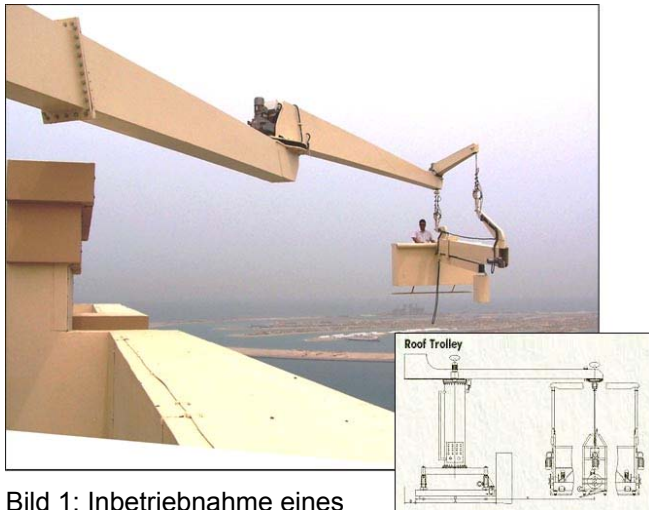
Bild 1: Inbetriebnahme eines Fassadenaufzugs in Dubai
